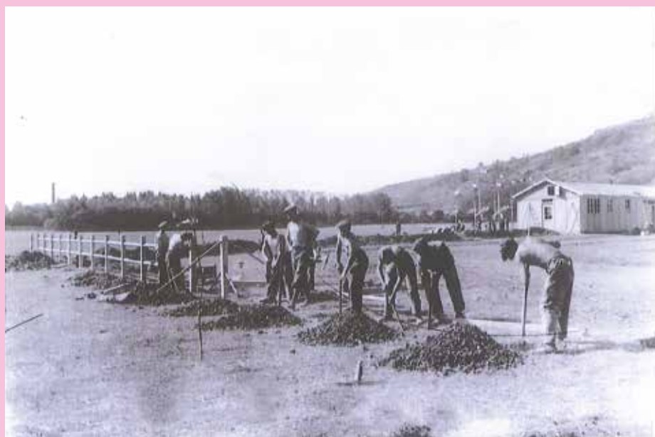
Construction du stade
